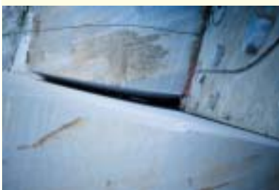
Operazioni di distacco del blocco con strumenti idraulici (hydrobag)
