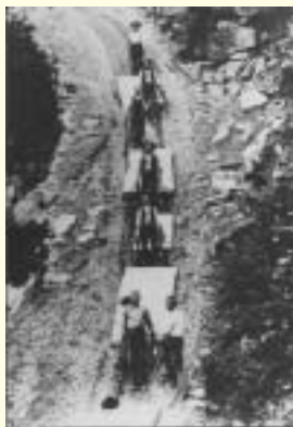
Trasporto delle lastre dalla cava al piano su slitte frenate a mano
