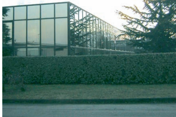
La palazzina uffici
