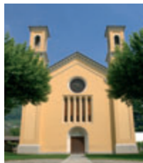
Torre Pellice, Tempio valdese
