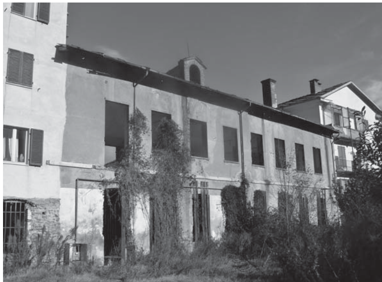
Ex setificio Sancio: porzione di fabbricato da ristrutturare
