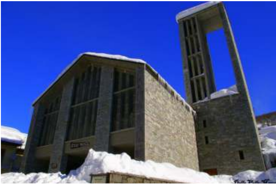
Il tempio valdese a Prali (foto Marco della Valle).
