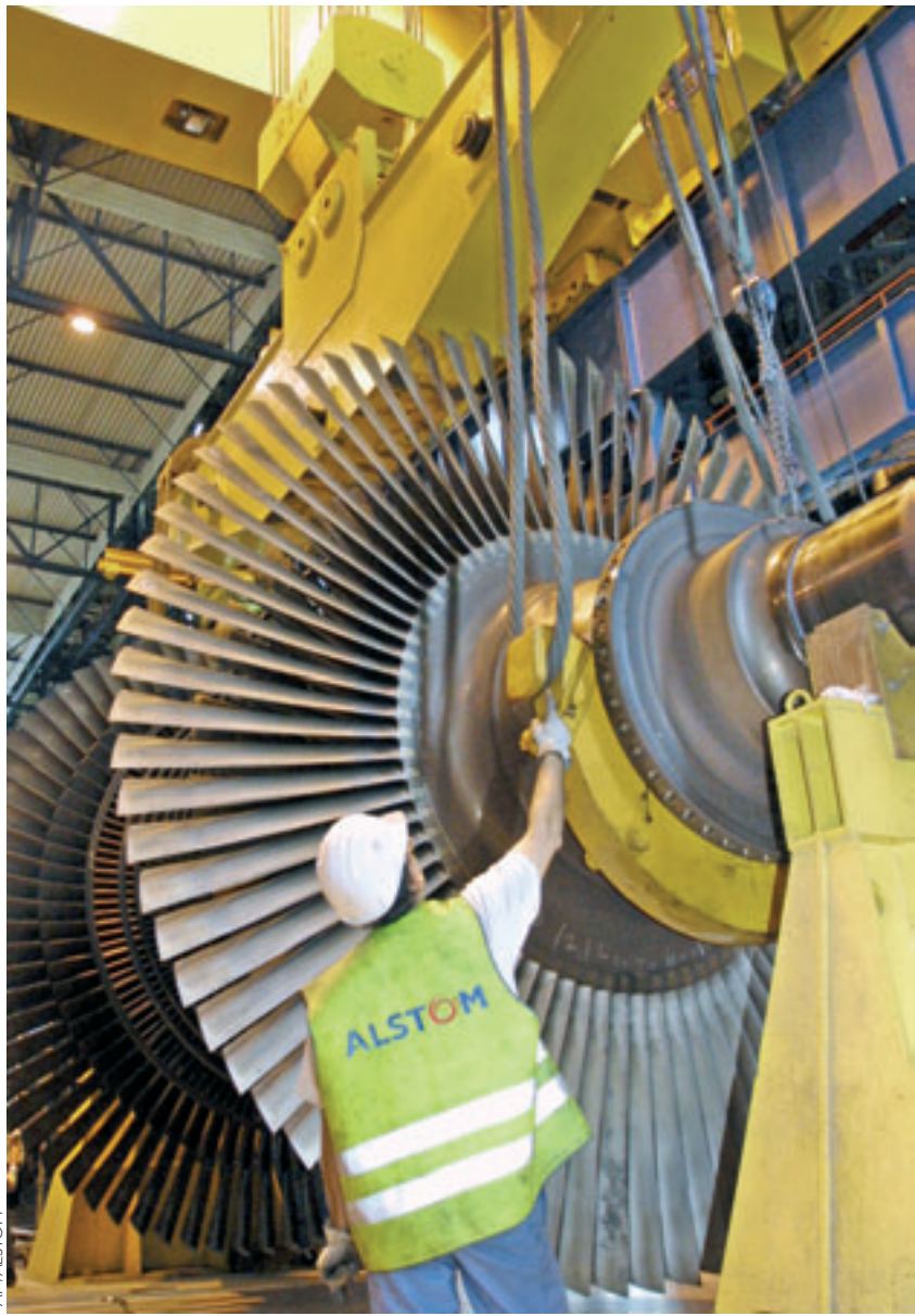
SAINT ALBAN, FRANCIA, SETTEMBRE 2003 Addetto alla manutenzione di una centrale nucleare
